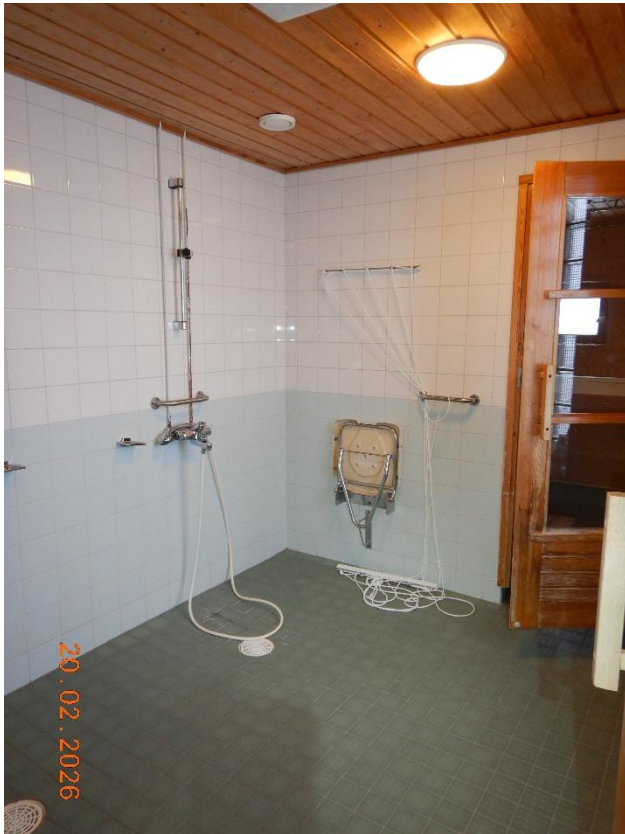
Kuvat 5 ja 6. Alkuperäisosien saunatilojen pesuhuoneiden laatoitusten laastit eivät sisällä asbestia.
