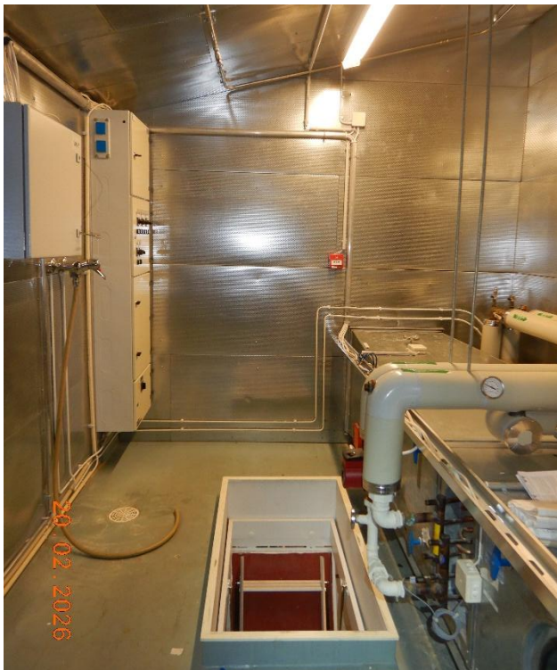
Kuvat 7 ja 8. Iv-konehuoneessa ei havaittu asbestipitoisia materiaaleja. Iv-konehuoneen lattiassa havaittiin vastaava sinivihreä muovimatto kuin alkuperäisosien kylpyhuoneissa.
