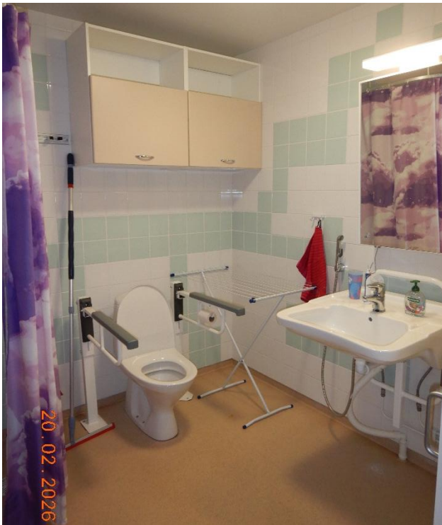
Kuvat 3 ja 4. Laajennusosan kylpyhuoneiden vaaleat muovimatot eivät sisällä raja-arvoa ylittävää määrää DEHP:tä, mutta ne tulee käsitellä PVC-jätteenä.
