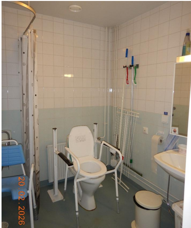
Kuvat 1 ja 2. Alkuperäisosien kylpyhuoneiden pintamateriaaleissa ei havaittu asbestia tutkittujen näytteiden perusteella. Sinivihreät muovimatot sisältävät raja-arvon ylittävän määrän DEHP:tä, joten ne tulee käsitellä vaarallisena jätteenä.
